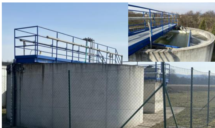
Do ČOV bude v priebehu najbližších rokov smerovať obecná kanalizácia, ktorej dobudovanie je hlavným zámerom obce.
